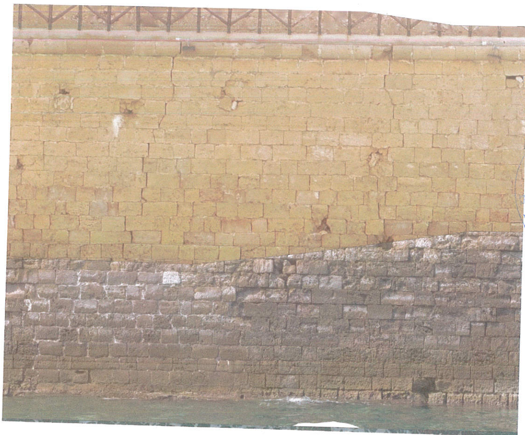
εικ. 38 Δύο διαμπερείς ρωγμές στην ανατολική όψη (ορθοφωτογραφία Α. Ντερής)
