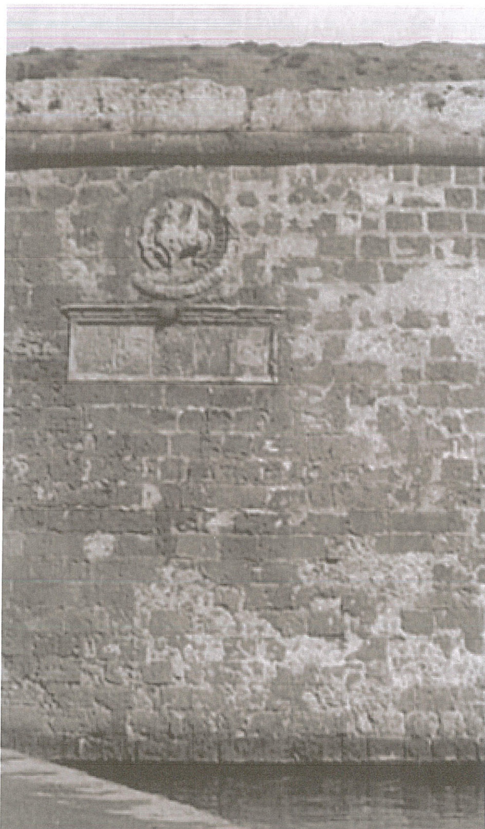
εικ. 40 Ρωγμή κάτω από το οικόσημο – Φωτογραφία αρχών 20ου αιω.
