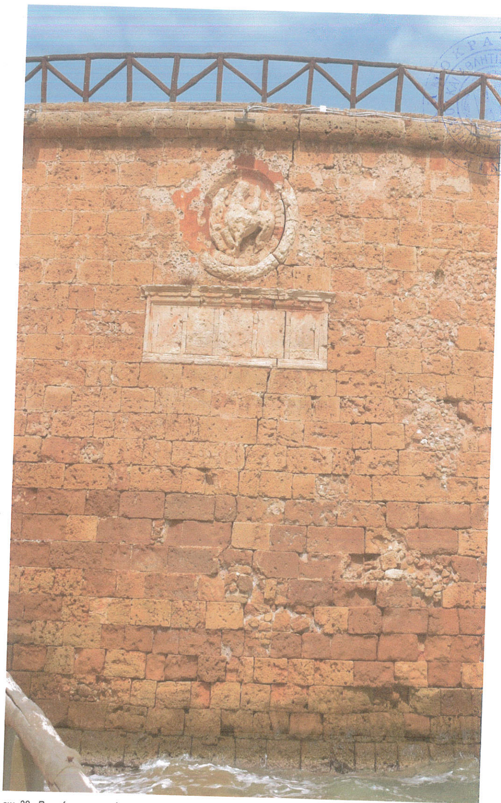
εικ. 39 Ρηγμάτωση στη νότια όψη (φωτ. Γ Χρυσάφκη)
