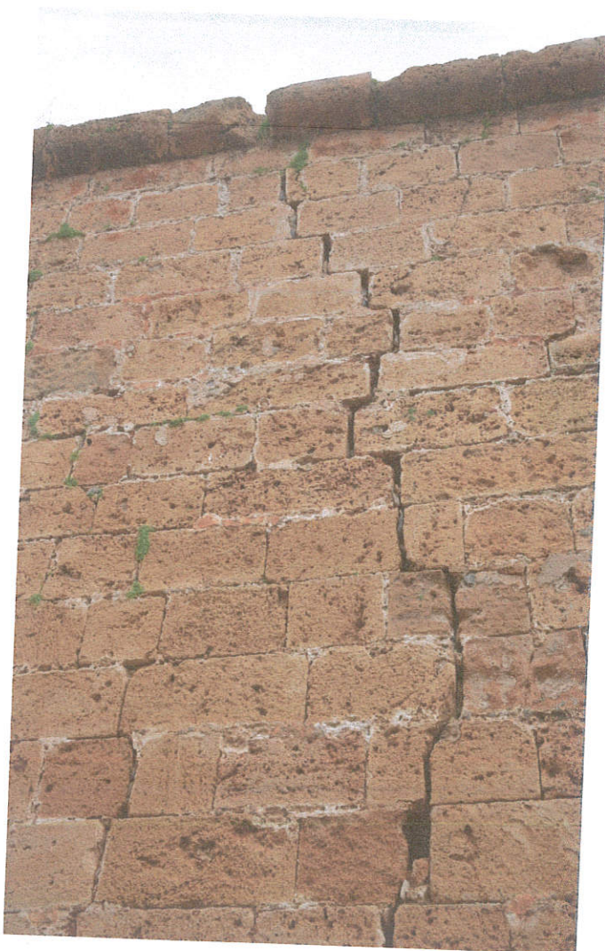
εικ. 37 Διαμπερή ρωγμή στη δυτική όψη (φωτ. Γ.Χρυσάφκη)
