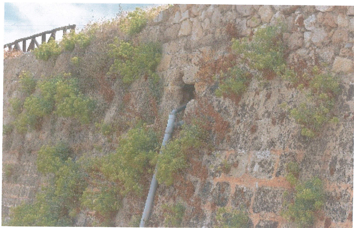
εικ. 42 Αυτοφυής παρασιτική βλάστηση και αυθαίρετες επεμβάσεις στο τείχος- Βόρεια όψη
