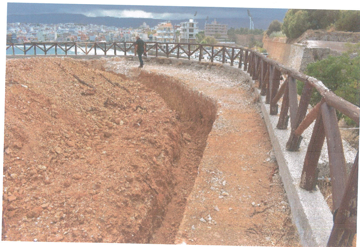
εικ. 24 Μπετονένιο στηθαίο και ξύλινο κιγκλίδωμα επί της στέψης του ενετικού τείχους (φωτ. Γ.Χρυσάφκη)
